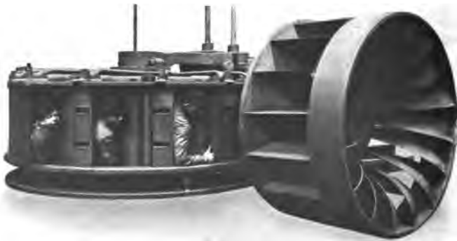
Fig. 29. Leitapparat und Laufrad der Francis-Turbine.
